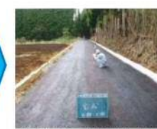
幅員拡張及び舗装整備の実施
