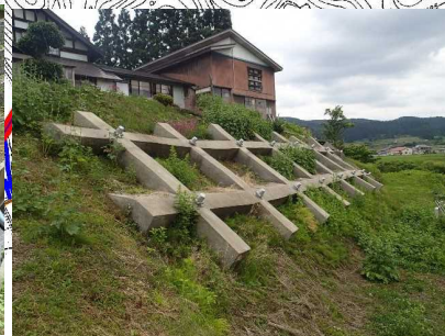
写真. 2 C-17 ブロック対策工 (平成 26 年施工)
