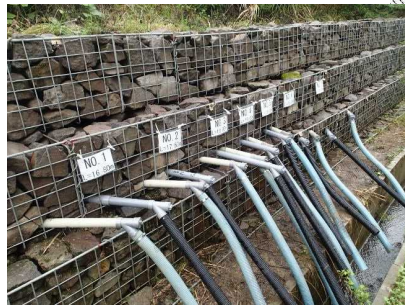
写真. 1 C-10-1 ブロック対策工 (令和元年 8 月施工)
