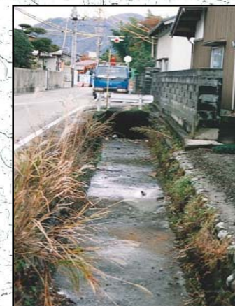
本郷江用水路 改修前
