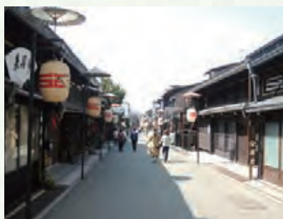
無電柱化した下二之町大新町地区
