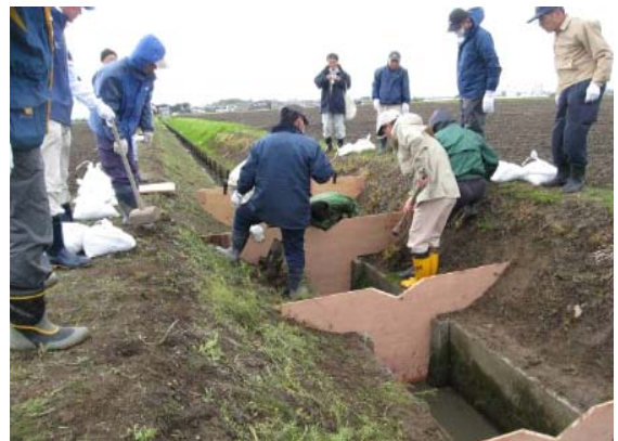
写真2 排水路に堰板の設置
