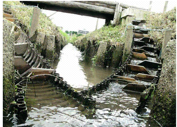
写真1 水田魚道の設置
