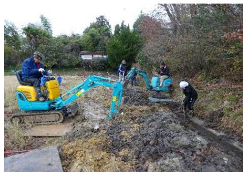
写真1 直営施工による改修
