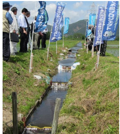
写真1 水田の排水路の堰上げによる全面魚道
