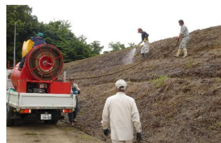
写真3 センチピードグラス吹き付け作業
