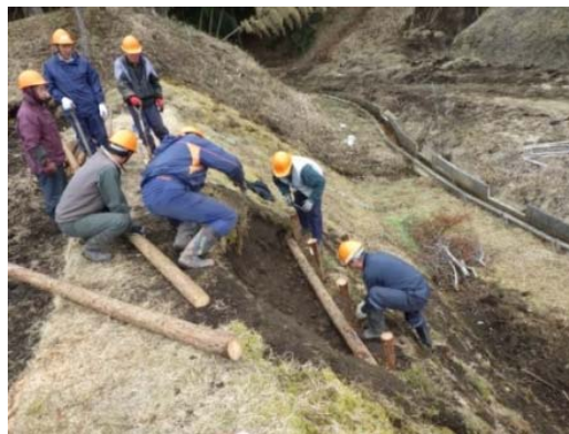
写真 4 構成員による法面復旧
