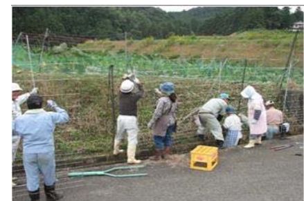
写真2 ワイヤーメッシュ防護柵 の設置
