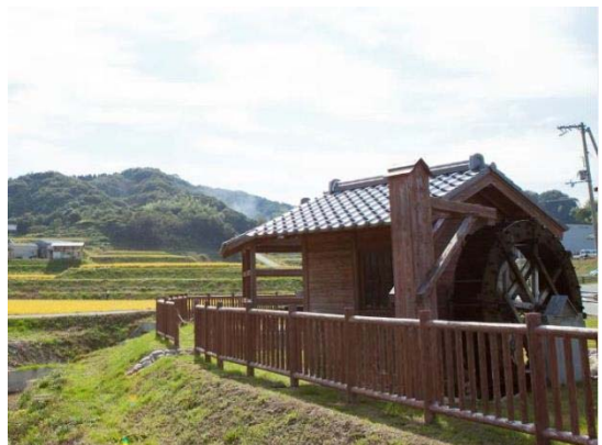
写真5 水車小屋公園
