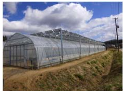
写真3 太陽光発電設備
