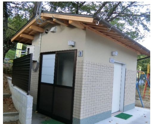
写真7 新設した多目的公衆トイレ
