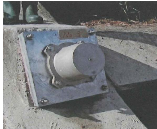
④頭部補修 コンクリートによる保護は、維持管理上適当でないため、調査後は原則として頭部キャップを採用する。頭部キャップの取り付けに対しアンカー頭部周辺の加工が必要。
