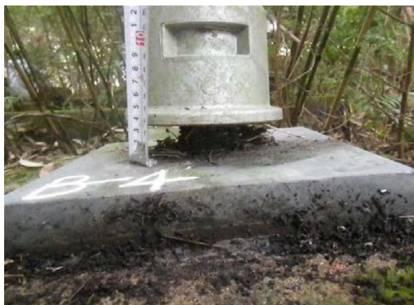
図 3-23 頭部キャップの浮き事例
