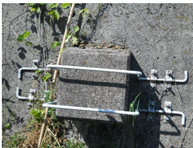
図 3-13 飛び出し防止対策例
