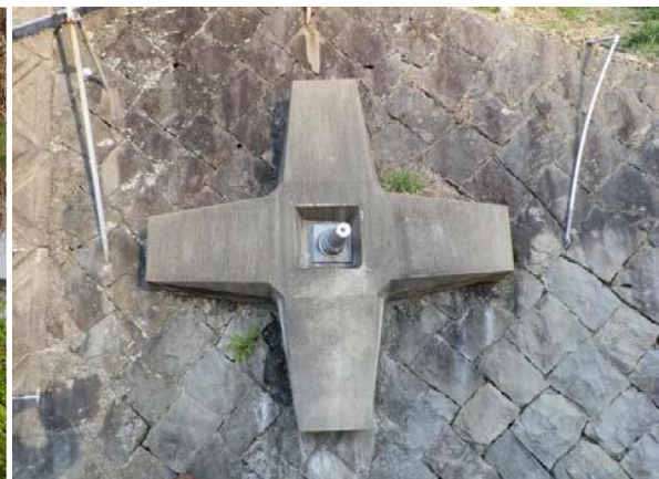
独立受圧板（コンクリート製）
