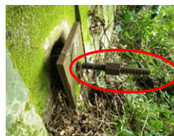
図3.6: テンドンの飛び出し
