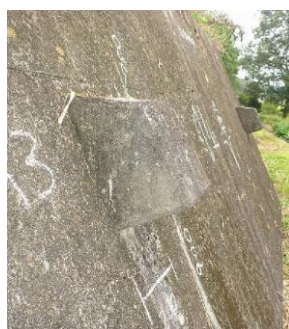
図2.2: 頭部コンクリートによる保護
