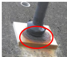
図3.4: プレートの変形
