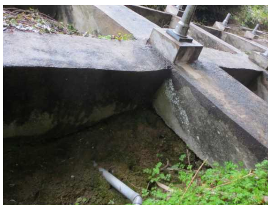
「中抜け」 (枠内の表土移動)
