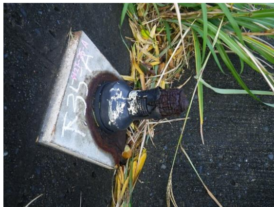
図 3-17 海岸近くで塩害の影響を受けたテンドンの腐食事例
