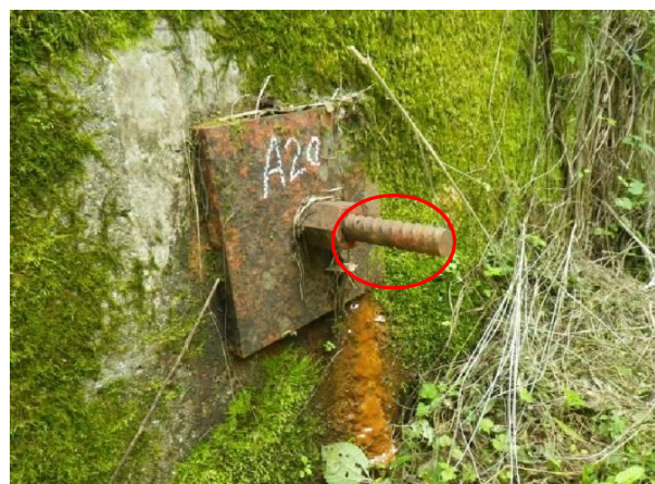
図 3-22 頭部保護がない場合のテンドンの腐食事例
