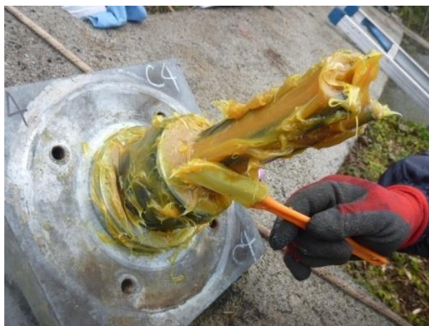
図 3-28 防錆油除去の状況
