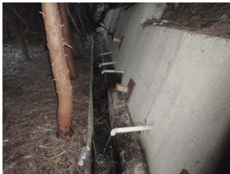
図2.5: 擁壁を受圧構造物とするアンカー工
