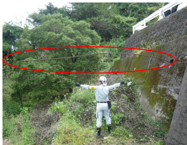
図 3-21 テンドンの飛び出し事例
