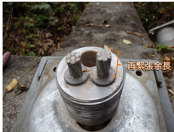
図 3-27 テンドンの再緊張余長部の例
