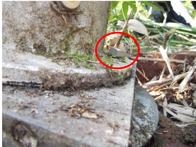
図 2-13 固定ボルトの緩みの事例
