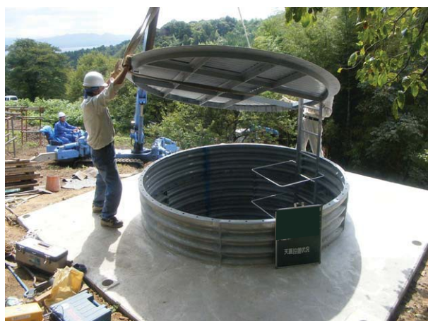
天蓋設置状況
