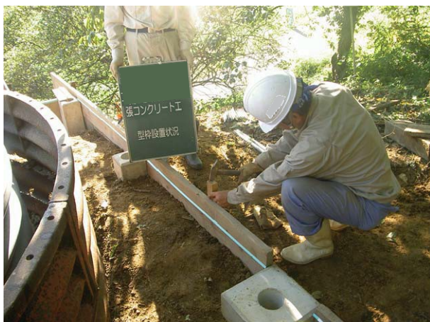
張コンクリート工型枠設置
