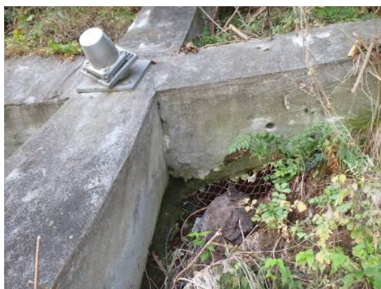
図 2-21 アンカー直下まで達するような大きな隙間の事例
