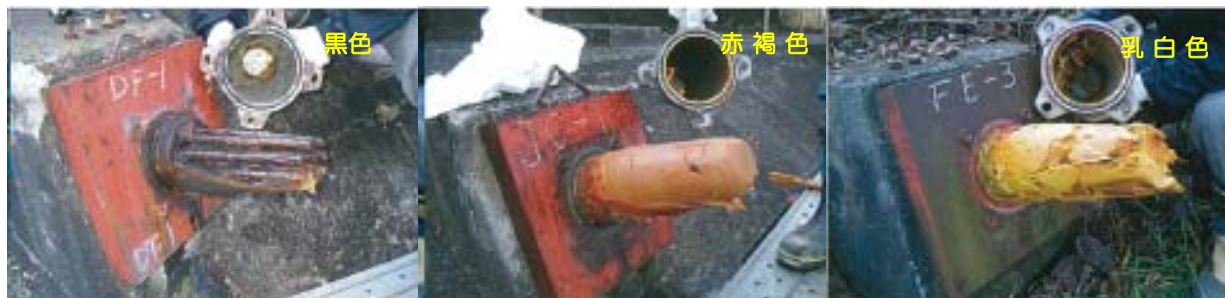
図 2-22 防錆油の劣化の事例
