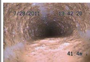
図 2.2.2 (1) 洗浄前の集水ボーリングの目詰り状況
