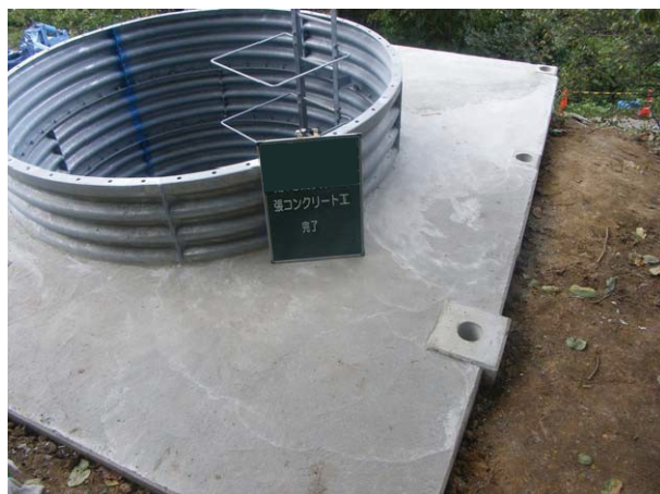
張コンクリート設置完了
