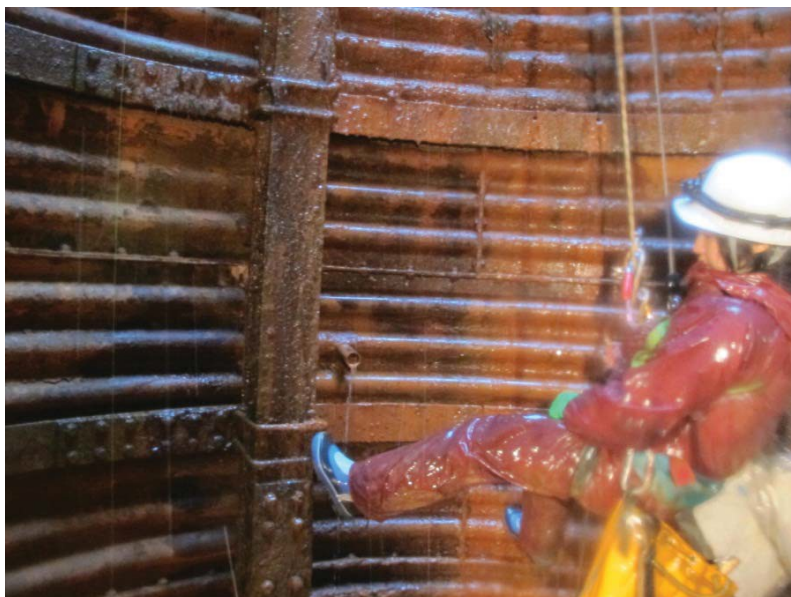
図－3 懸垂下降による詳細調査事例
