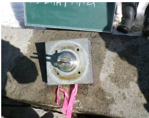
図 4-1 頭部露出調査例
