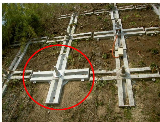
図 2-7 再設置されたアンカーの例
