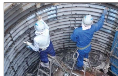
図3 集水井内塗装作業状況
