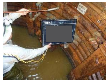
孔内カメラ測定状況
