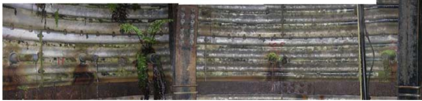
図 2.3.2 (3) 洗浄前の集水ボーリングの目詰まり状況
