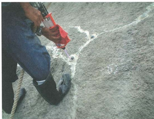
図 3.1 ひびわれ補修工法の施工例（ひび割れへの充填材の注入作業）
