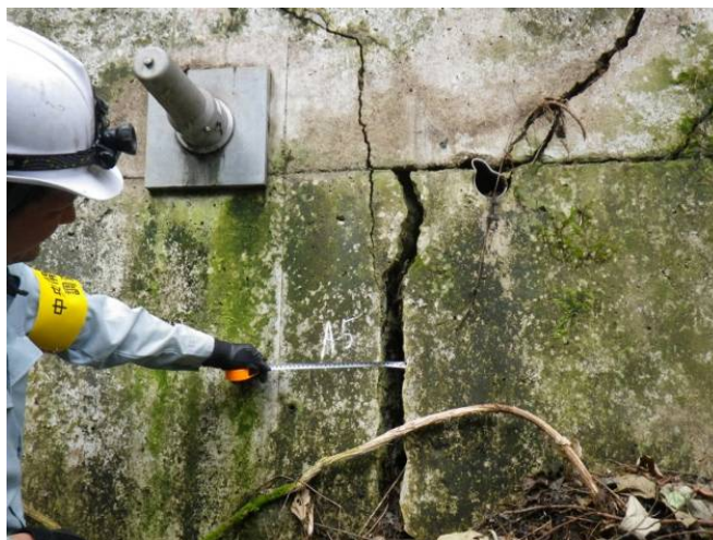
図 2-19 受圧構造物に生じたひび割れ、段差等を伴うひび割れの事例
