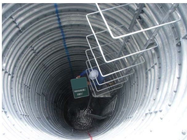
点検梯子設置状況
