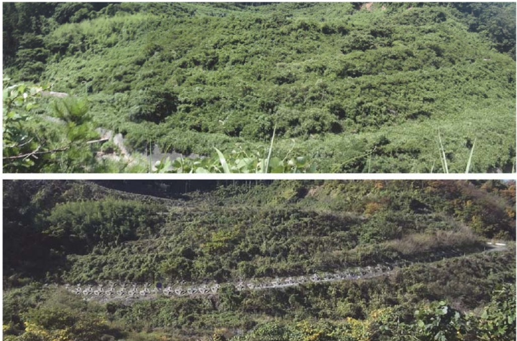
写真1 草刈り作業前後の現地状況（遠望）
