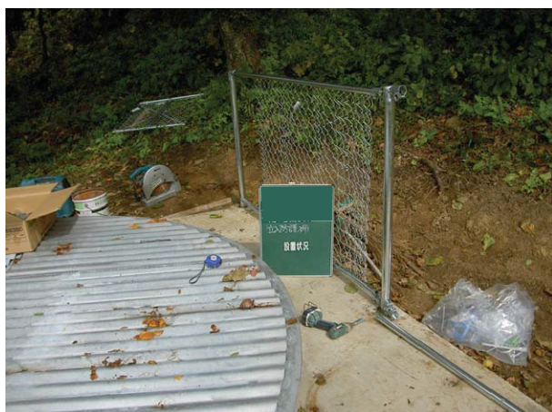
安全柵取付状況
