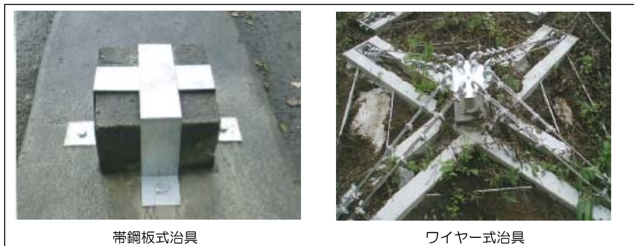
図 2-6 テンドンの飛び出し防止対策の例
