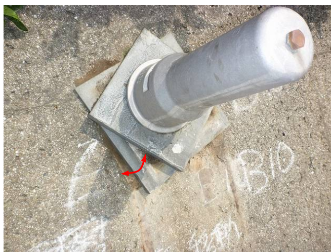
図 2-15 プレートが人力で回転可能な事例
