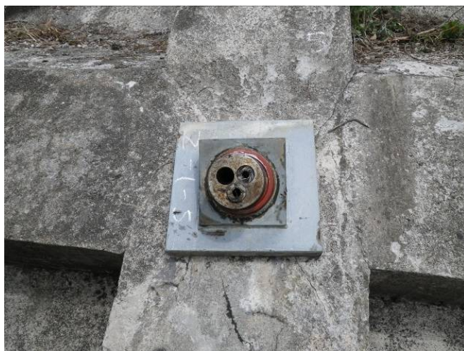
図 2-24 テンドンの引き込まれの事例
