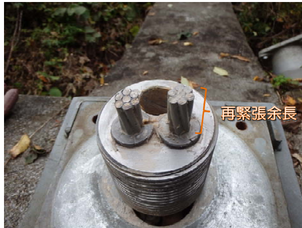
図XI-2.3.2 テンドンの再緊張余長部の例
