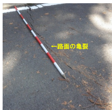
図XI-2.1.3 道路やコンクリート構造物に見られる変状の例
