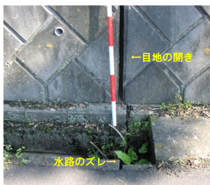
図XI-2.1.3 道路やコンクリート構造物に見られる変状の例
