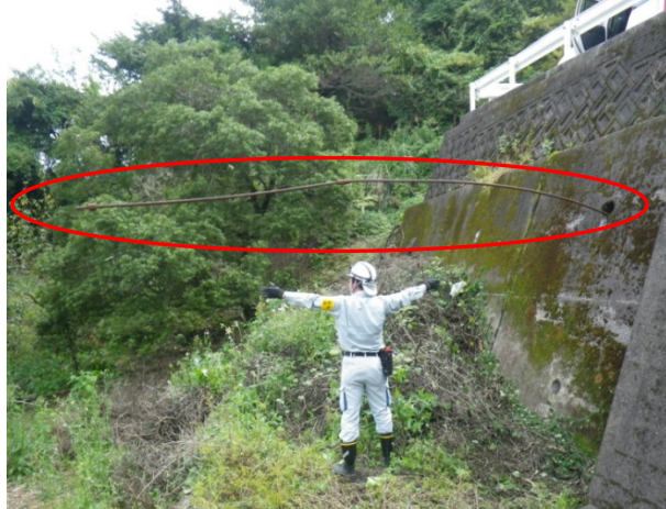
図XI-2.2.2 テンドンの飛び出し事例
