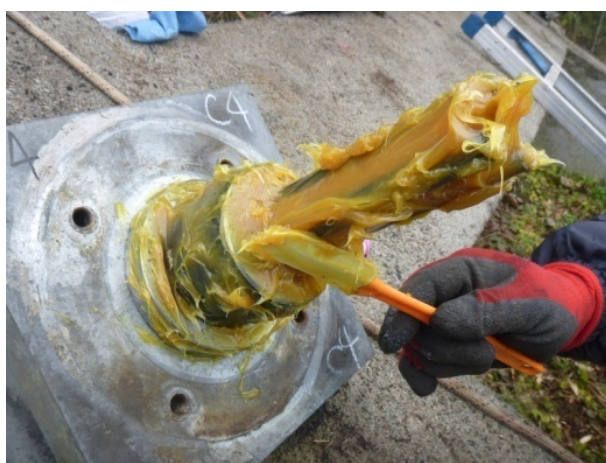
図XI-2.3.3 防錆油除去の状況
