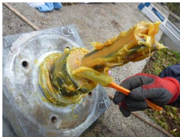
図XI-2.3.3 防錆油除去の状況
