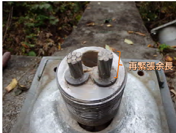
図XI-2.3.2 テンドンの再緊張余長部の例
