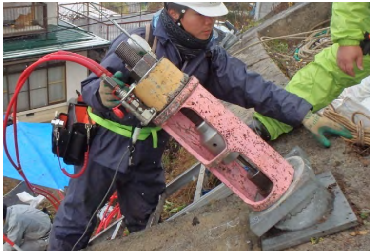
図XI-2.3.7 リフトオフ試験状況（小型軽量ジャッキ）
