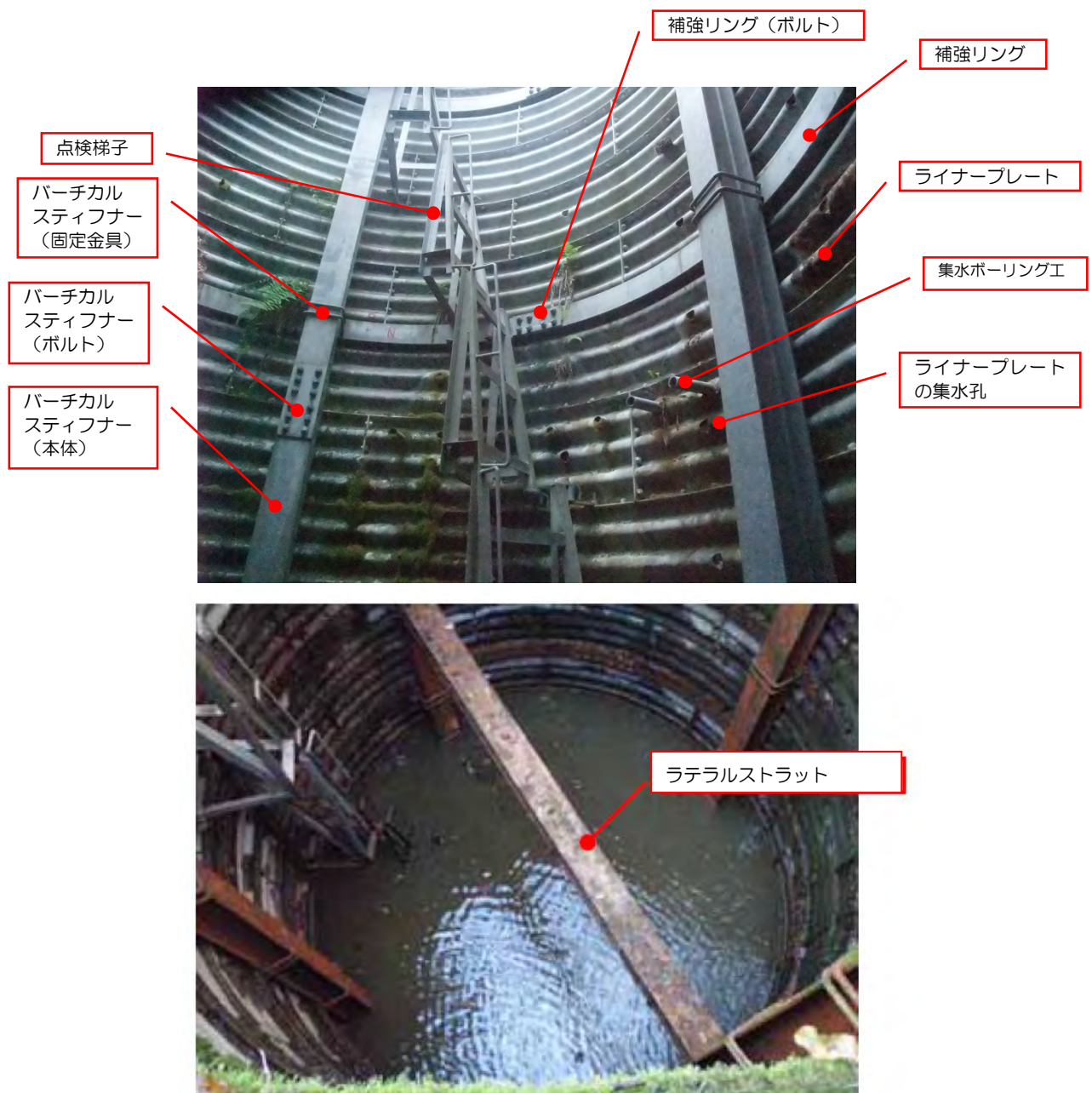
図IV-1.1.2 集水井工の内部の例（写真）
