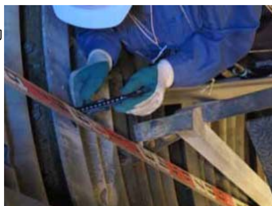
図Ⅳ-2.3.8 下げ振り測定
