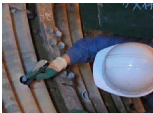
図Ⅳ-2.3.7 部材の残存厚さ測定
