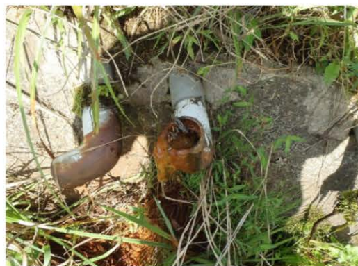
施設の状況(近景)
