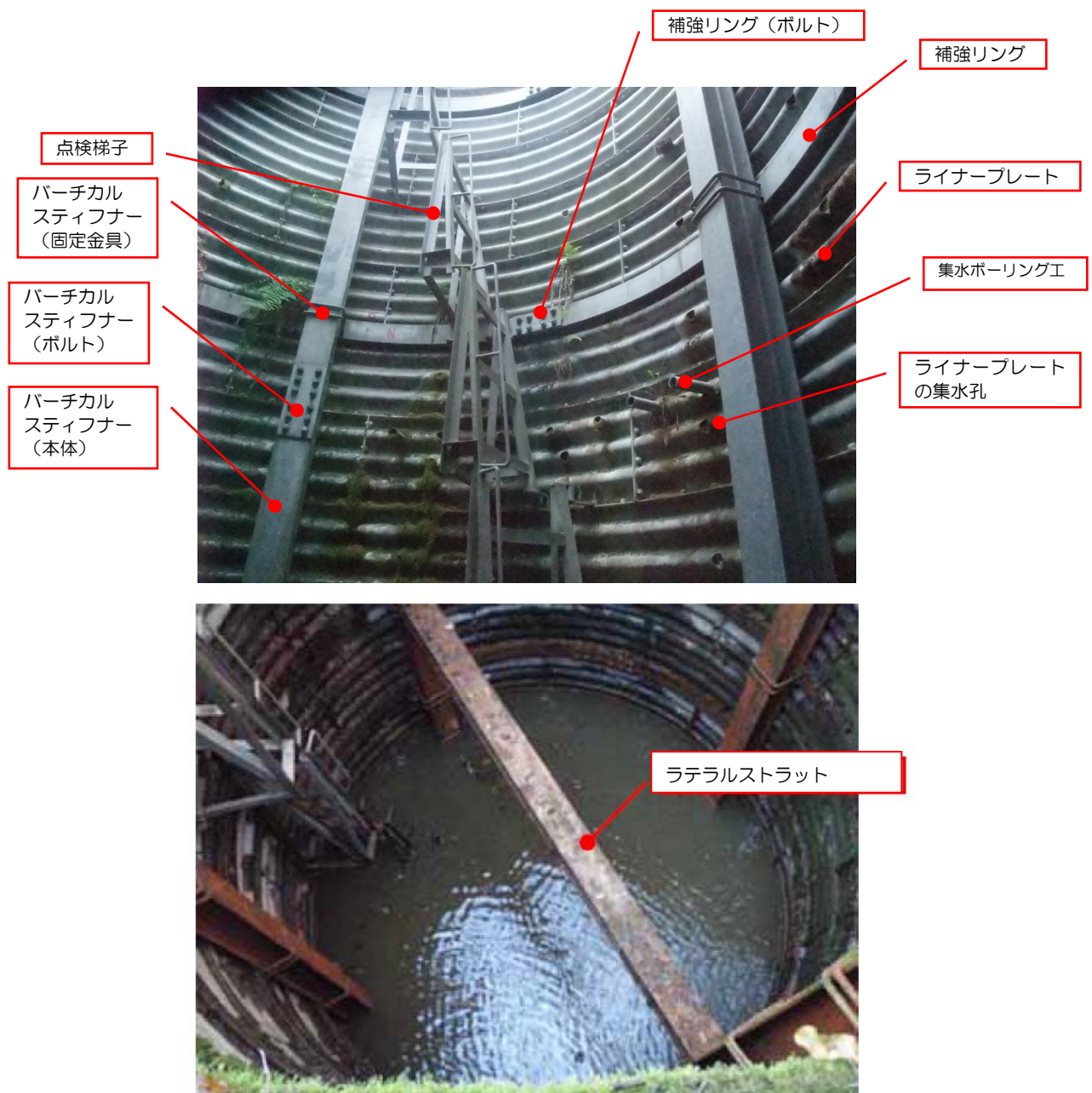
図IV-1.1.2 集水井工の内部の例（写真）
