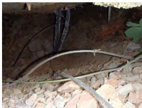
図 2-21 アンカー直下まで達するような大きな隙間の事例
