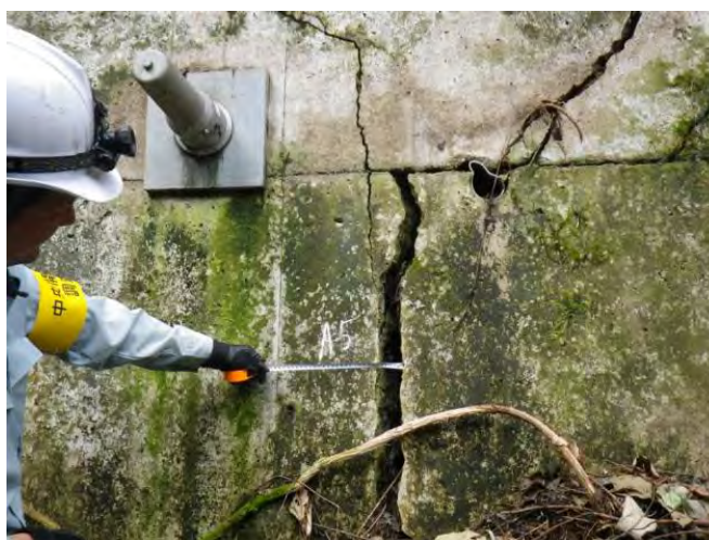
図 2-19 受圧構造物に生じたひび割れ、段差等を伴うひび割れの事例
