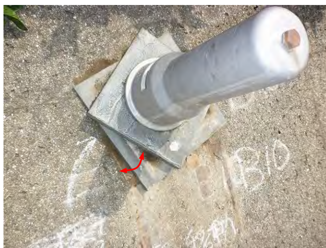
図 2-15 プレートが人力で回転可能な事例
