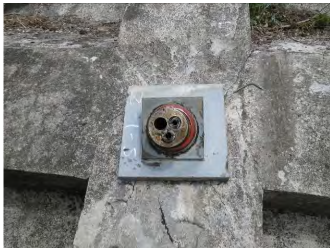
図 2-24 テンドンの引き込まれの事例
