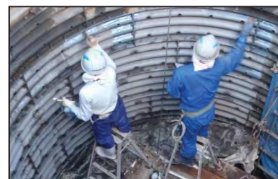
図3 集水井内塗装作業状況
