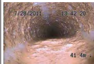
図 2.2.2 (1) 洗浄前の集水ボーリングの目詰り状況
