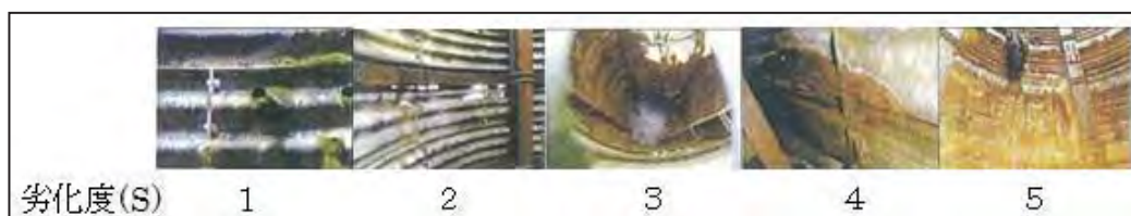
図 1 集水井ライナープレートでの目視による劣化度評価事例
