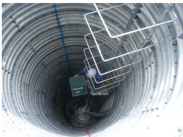
点検梯子設置状況
