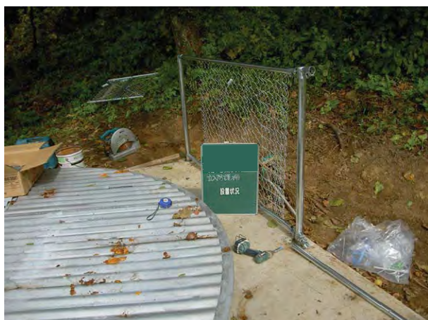
安全柵取付状況
