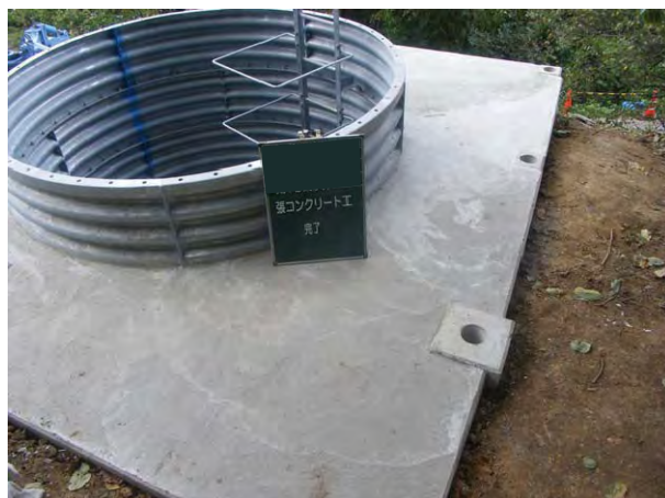
張コンクリート設置完了
