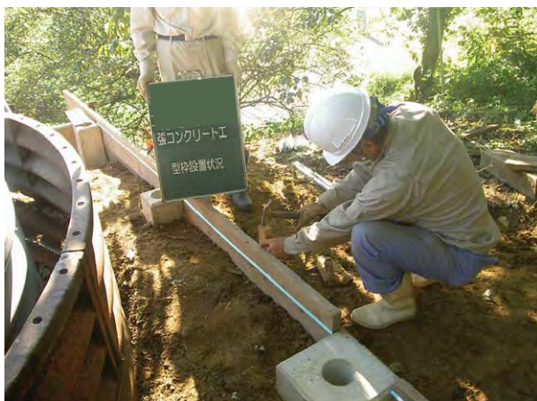
張コンクリート工型枠設置
