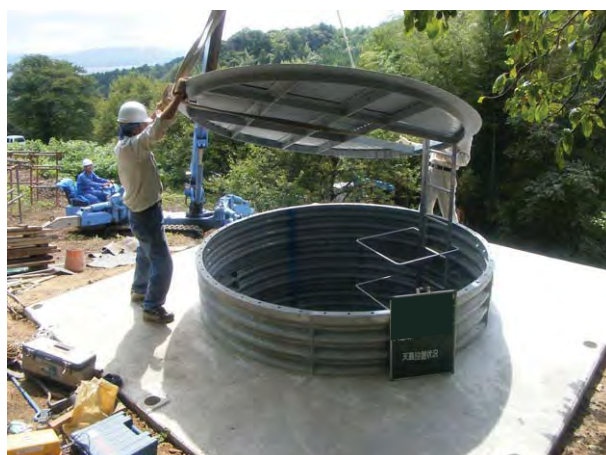
天蓋設置状況
