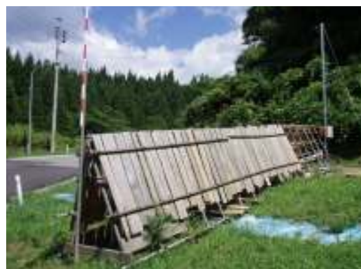
写真-5.4.2 地表伸縮計の雪囲い例
