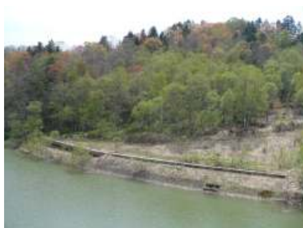
図-4.3.2 地すべりの水没状況
