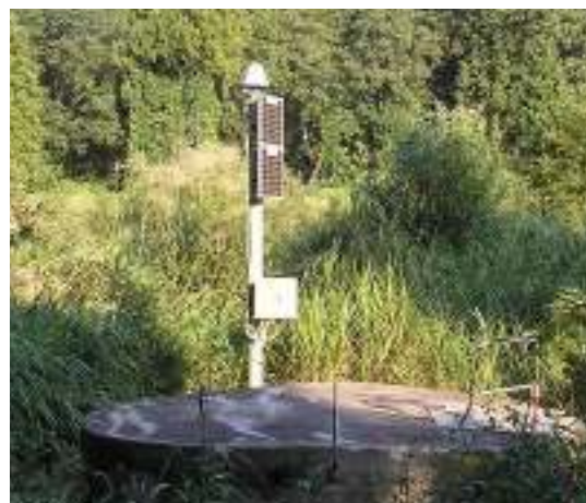
写真-5.4.1 GPS観測施設の設置
