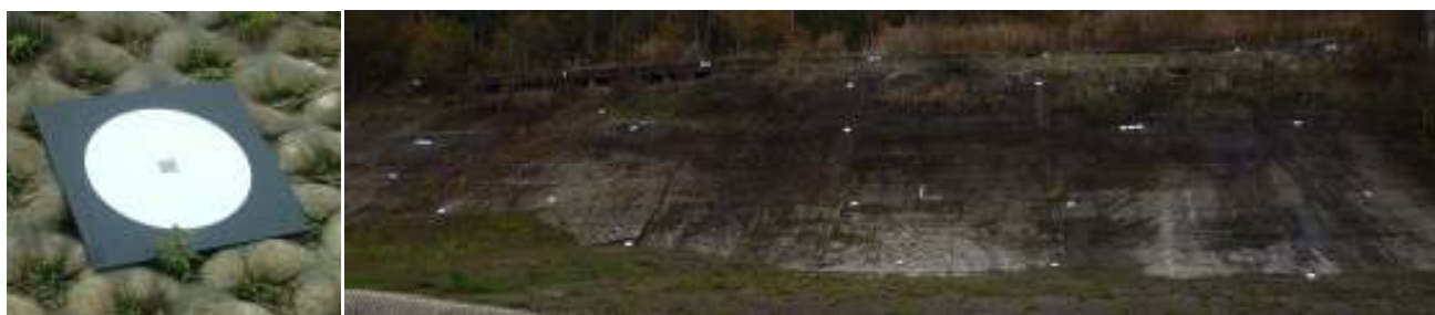
図-5.3.3 地すべり下部におけるターゲット設置状況
