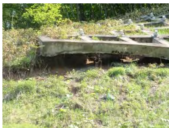
図XI-2.2.7 アンカーの受圧構造物が不安定化しつつある例
