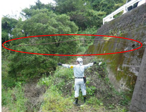
図XI-2.2.2 テンドンの飛び出し事例
