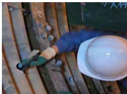
図Ⅳ-2.3.7 部材の残存厚さ測定
