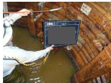
孔内カメラ測定状況
