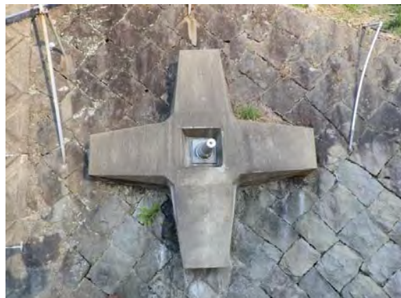
独立受圧板（コンクリート製）
