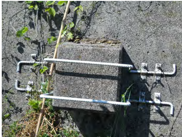
図XI-2.1.4 飛び出し防止対策例
