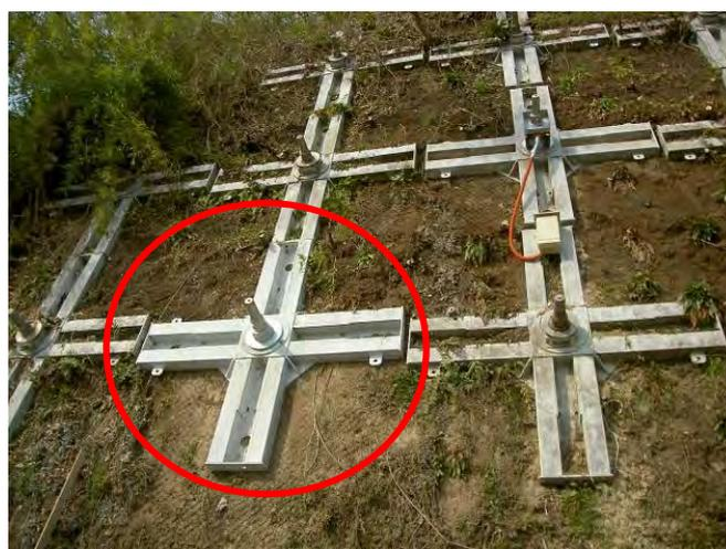
図 2-7 再設置されたアンカーの例
