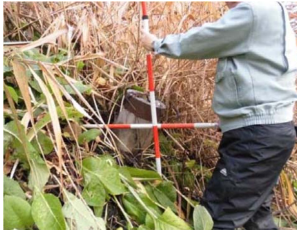
図 2.1 地中構造物の点検事例（杭の突出・傾倒）
