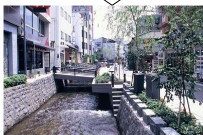
整備後の鞍月用水 (開渠化)
