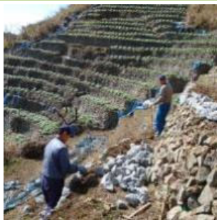
石垣の修復の様子
