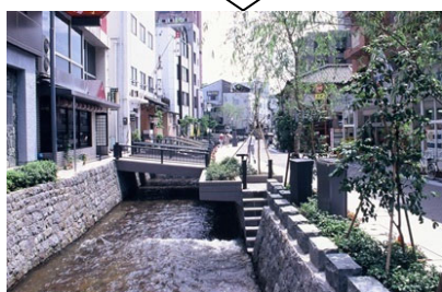
整備後の鞍月用水（開渠化）
