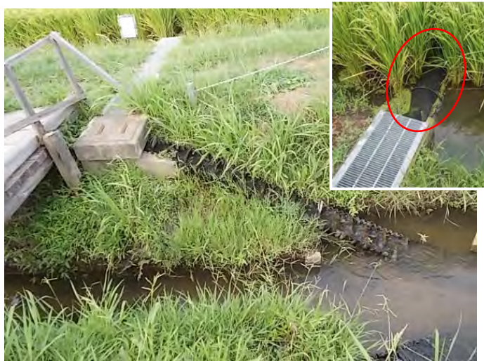
↑水田魚道 ドジョウ等が水田と水路とを行き来
