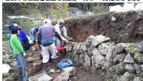
「空積みワークショップで石積み補修技術を継承」
