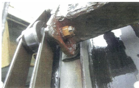
写真 6.2 レーキ取付けボルトの調査
