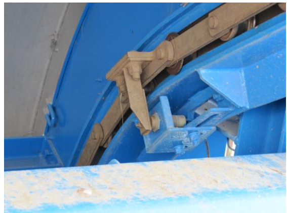
写真 5.4 ガイドレールの調査
