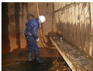
写真 6.1 ボルトのテストハンマ打診状況
