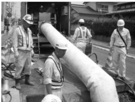
写真 5.5.2-1 反転工法（圧力容器による）の挿入風景
