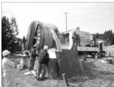
写真 5.5.2-5 形成工法（熱形成タイプ）の挿入風景
