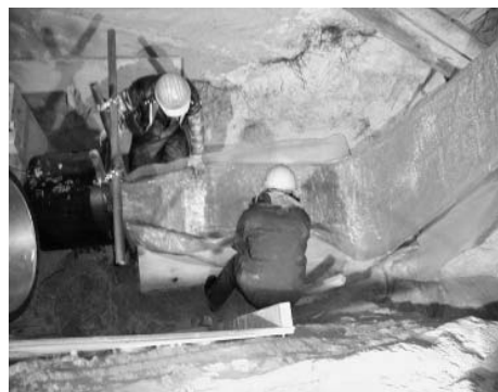
写真 5.5.2-4 形成工法（熱・光硬化タイプ）挿入風景
