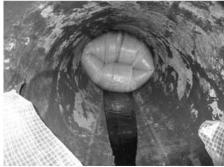
写真 5.5.2-3 管内反転状況
