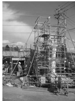
写真 5.5.2-2 反転工法（水圧による）の挿入風景
