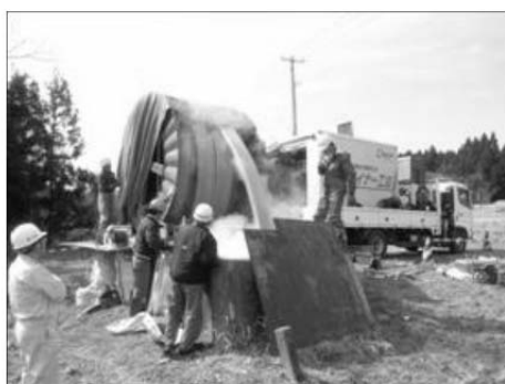
写真 5.5.2-5 形成工法（熱形成タイプ）の挿入風景
