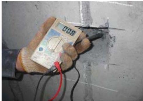
図 4.3-30 鉄筋ハツリ出し・導通確認例
