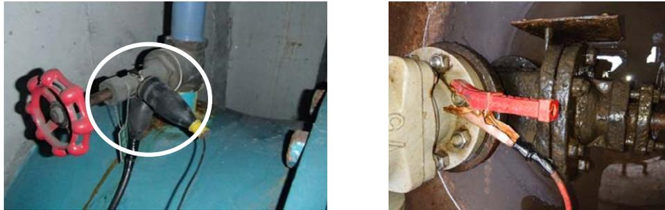
計装配管への測定線接続例
