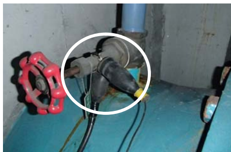
計装配管への測定線接続例
