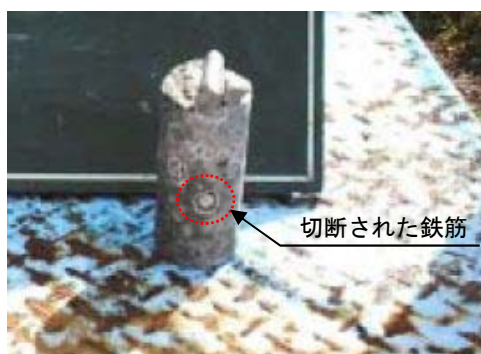
図 4.3-32 鉄筋切断状況例
