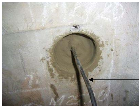
図 4.3-14 止水状況
