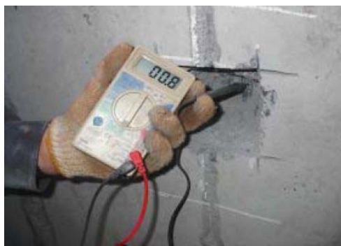
図 4.3-30 鉄筋ハツリ出し・導通確認例
