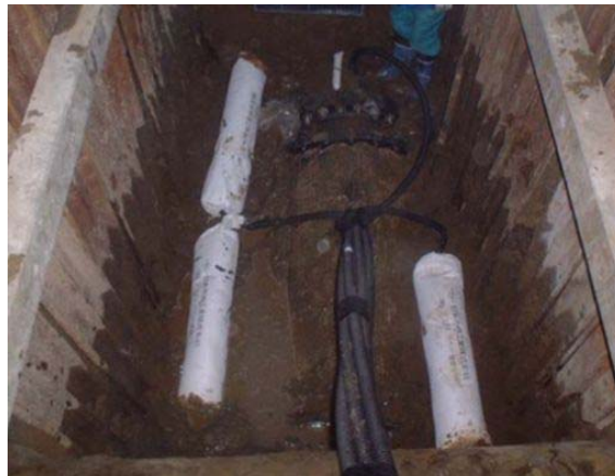
図 4.3-16 Mg 陽極設置例
