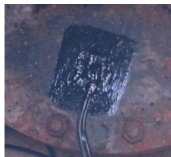
取付け部プライマー処理
