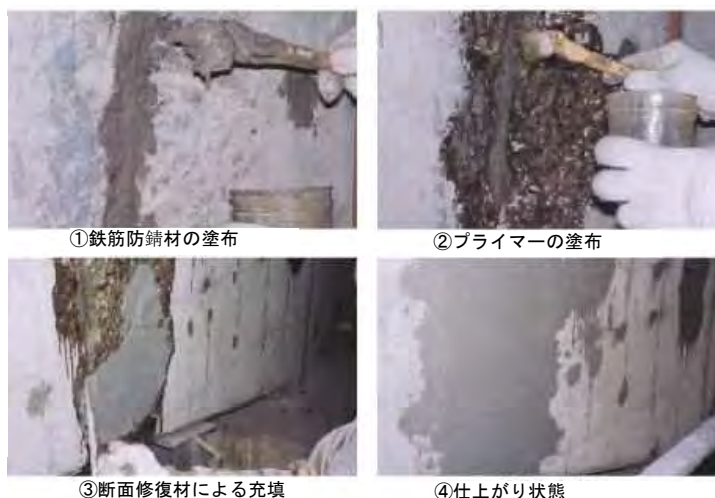
図 5.3-4 断面修復工法概念図（例）
