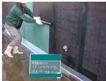
【対策工施工状況】
