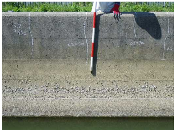
図 3. 2-1 乾燥収縮ひび割れの発生イメージ
