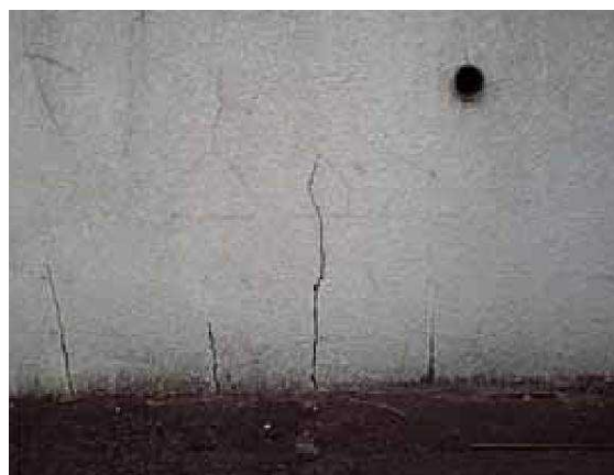
図 3.2-4 温度ひび割れの発生イメージ
