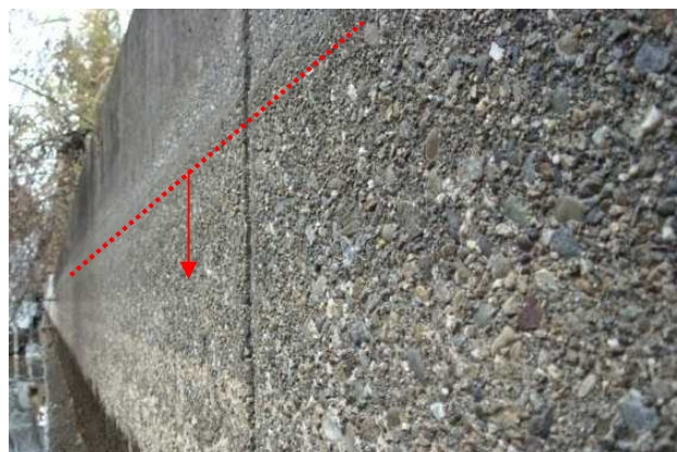
図 3. 3-2 喫水線下部に生じた摩耗
