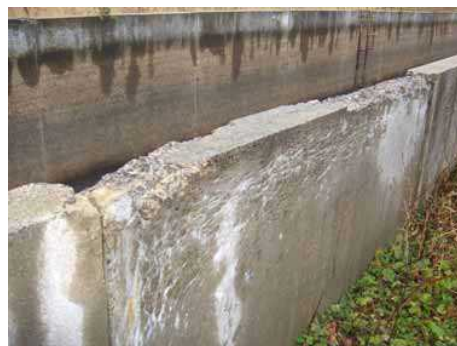
図 3.3-9 目地部に生じる特徴的な凍害
