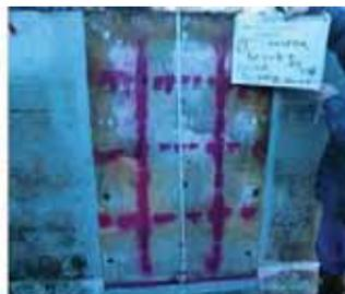
裏込め材の状況天端20cm程度中酸化
