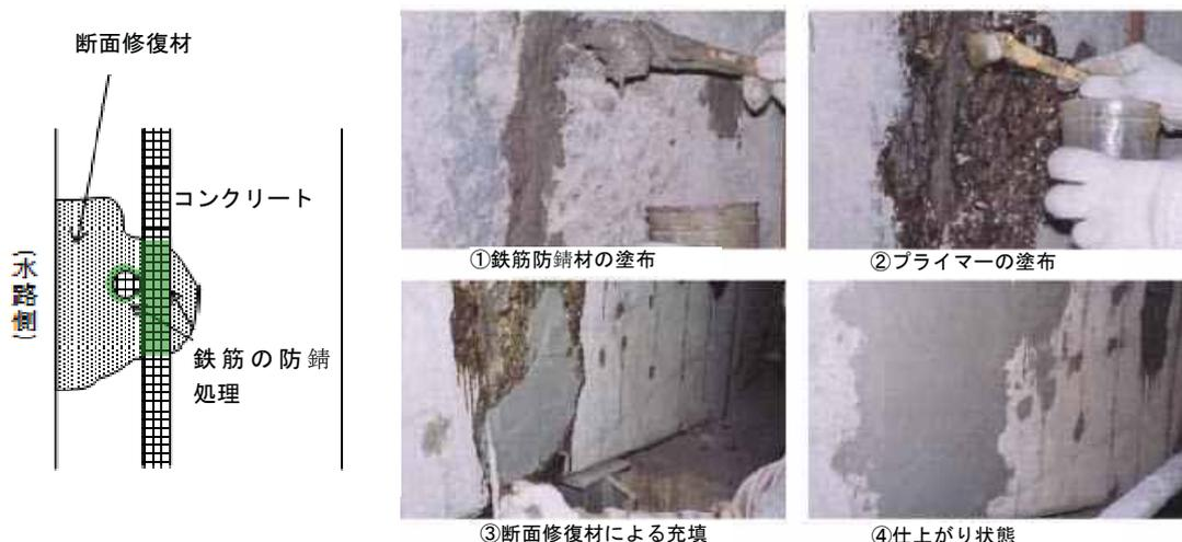
図 5.3-4 断面修復工法概念図（例）
