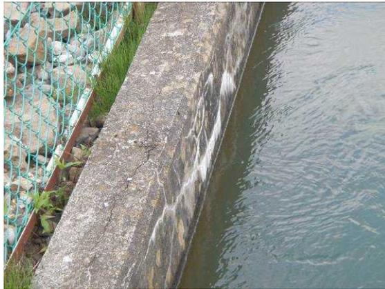
図 3.3-14 アルカリシリカ反応による亀甲状のひび割れとゲルの滲み出し
