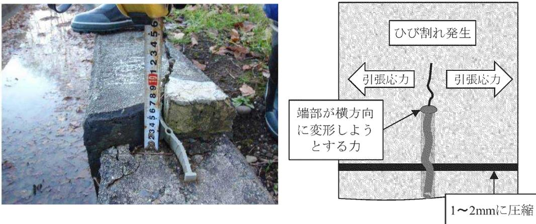
図 3.4-10 止水板から長手方向に生じたひび割れ
