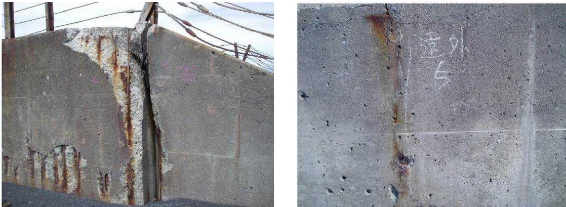
図 3.3-37 塩害による変状
