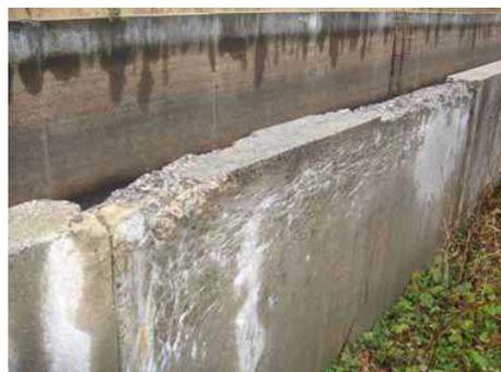
図 3.3-9 目地部に生じる特徴的な凍害
