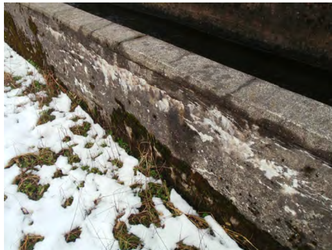
【側壁のひび割れ等の変状発生状況】
