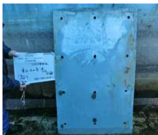
FRP板には裏込め材がほとんど付着しない
