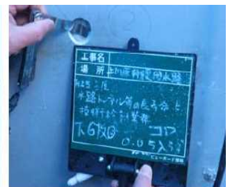
アンカー部の隙間無し（パネルと充填材の密着性）
