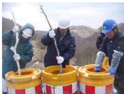
写真-c 石灰水を攪拌している状況
