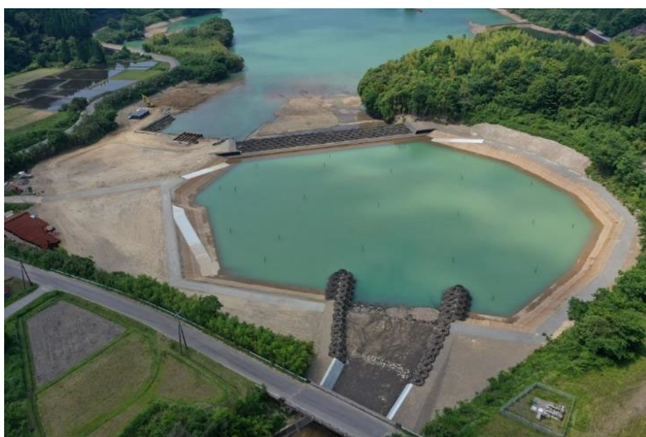
沈砂池全景写真
