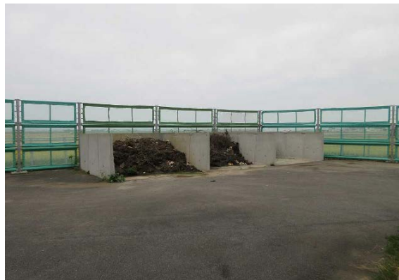
写真-7. 参1 防風ネット設置状況
